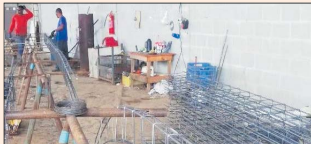
A KL trabalha com colunas, esteiras, treliças, colunas prontas e ferragens em geral
